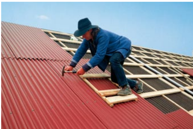
Altdachsanierung mit Bitumenwellplatten
