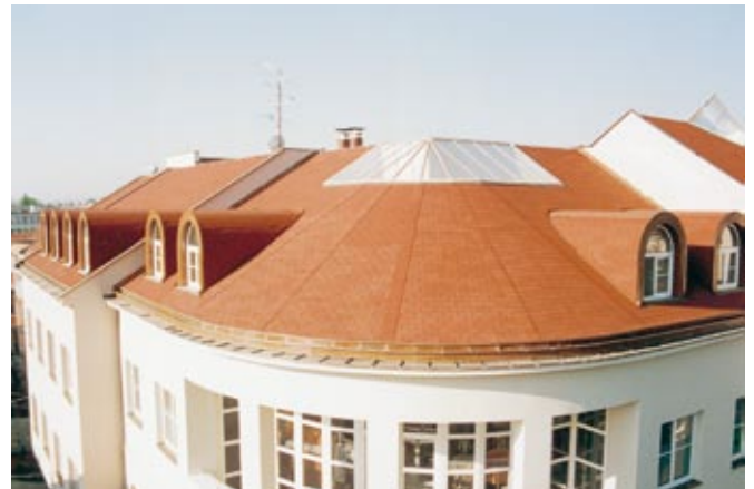
Gartenhaus mit Bitumenwellplatten
